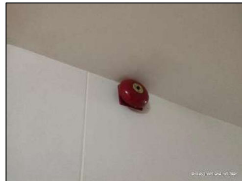
รูปที่ 2-31 กริ่งสัญญาณเตือนอัคคีภัย
