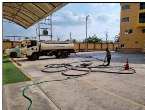
รูปที่ 2-12 ผู้รับเหมามาสูบกากตะกอนออกจากบ่อ เมื่อบ่อเกรอะเต็ม
