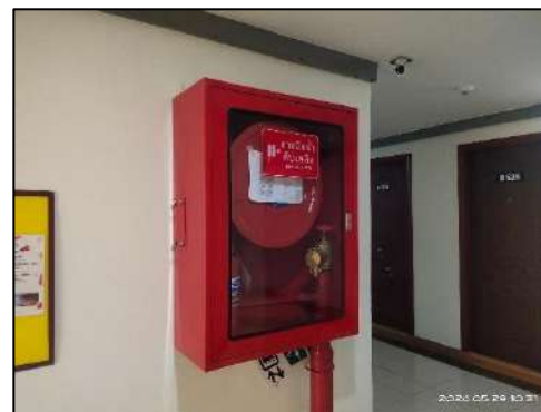
รูปที่ 2-26 ตรวจสอบระบบป้องกันอัคคีภัย
