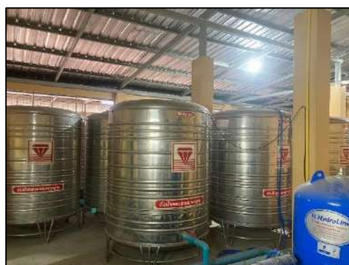
รูปที่ 2-13 จัดให้มีถังสำรองน้ำใช้บนดิน และถังสำรองน้ำใช้ชั้นหลังคา
